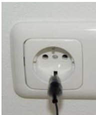
ANSCHLUß AM GEERDETEN SCHUTZLEITER DER STECKDOSE
